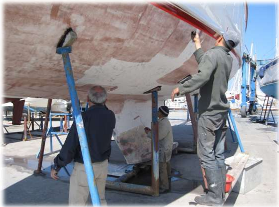
Première couche, tous dans le même sens. On constate la transparence du produit
