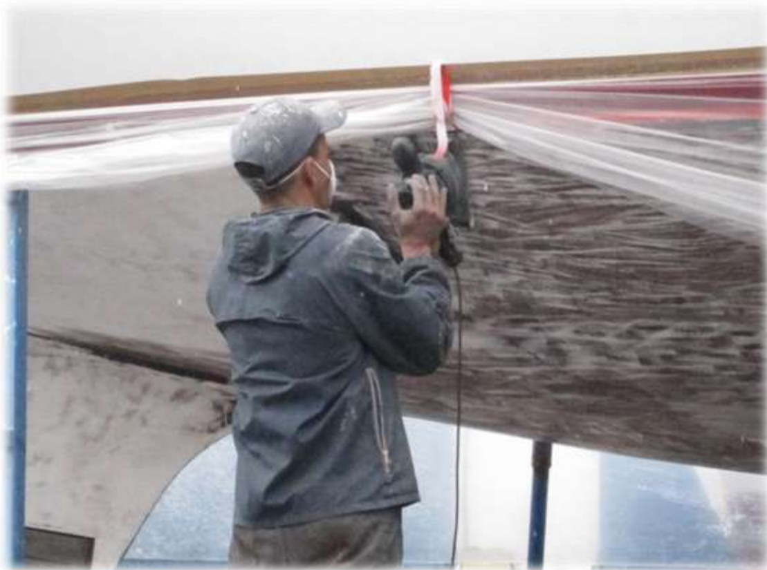
Ponçage avec vibrante ou orbitale
